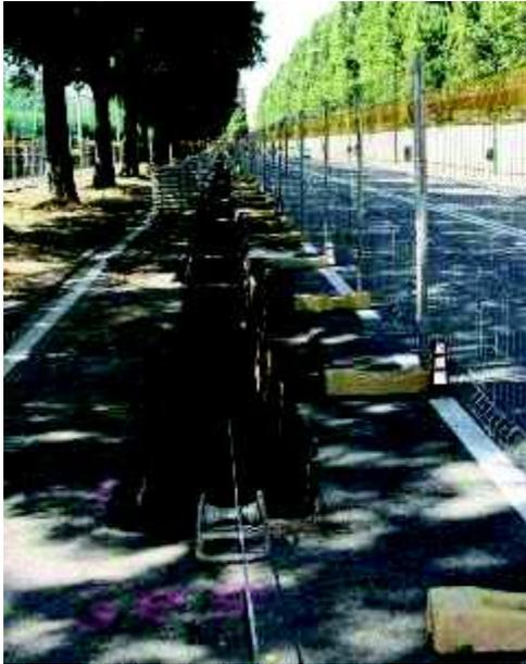
**Photo 5 – Ouverture d’une tranchée pour poser les fourreaux, cliché TERNA**
