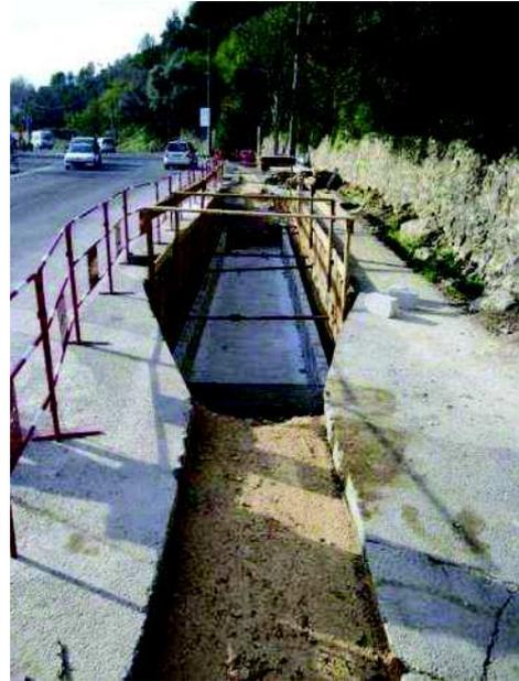
**Photo 6 – Chambre de jonction pour le déroulage des câbles, cliché RTE**
