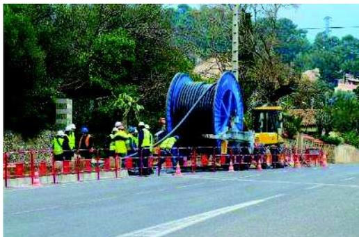
Photo 4- Vue d'un chantier de construction d'une ligne souterraine sous chaussée, source RTE
