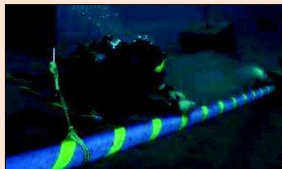
**Photo 8 – Suivi de la pose du câble par un plongeur cliché TERNA**
