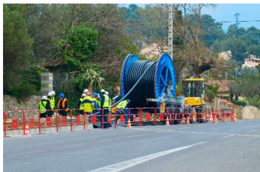
Photo 3- Vue d'un chantier de construction d'une ligne souterraine sous chaussée, source RTE
