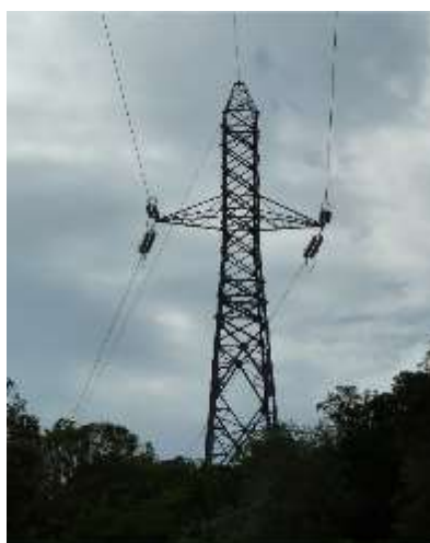
Photo 1 - Vue de la ligne aérienne en Corse, source EDF
