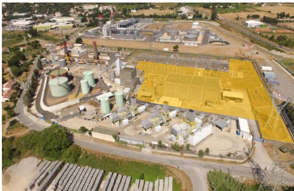
Photo 2 – Exemple de la station de conversion actuelle de Lucciana (en orange) au sein du site industriel EDF (source EDF)
