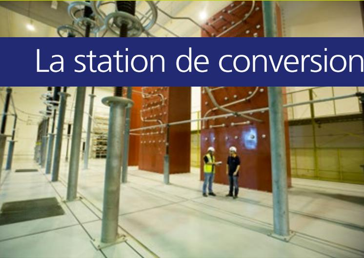
Permettant de convertir le courant continu de la liaison SACOI en courant alternatif pour le réseau électrique corse, la station de conversion de Lucciana joue un rôle pivot dans l'alimentation électrique de la Corse. Construite il y a près de 35 ans, ses équipements de haute technologie sont aujourd'hui obsolètes. Pour assurer sa pérennité et accueillir l'augmentation de puissance nécessaire à l'alimentation électrique de la Corse, elle doit être reconstruite.
