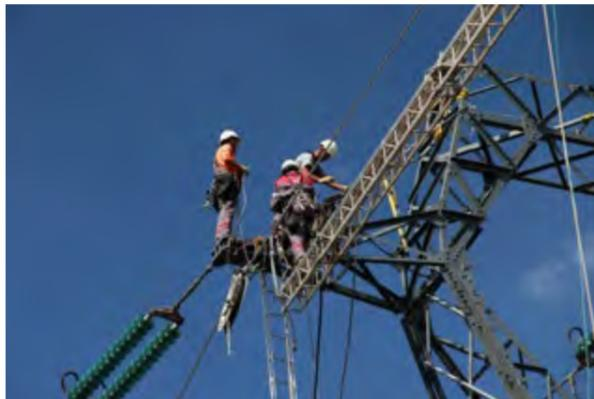
Les câbles sont remplacés par tronçon d'une dizaine de pylônes, soit environ 3 à 4 km. Les équipements – dérouleuses, freineuses et tourets de câbles – sont installés sur des plateformes créées à chaque extrémité du tronçon où le déroulage va être réalisé.
