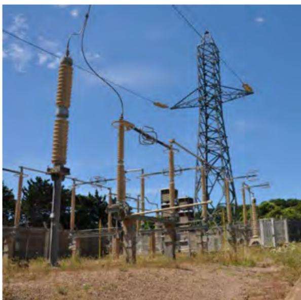
La nouvelle ligne aérienne est raccordée à la nouvelle ligne souterraine dans un poste de transition.
